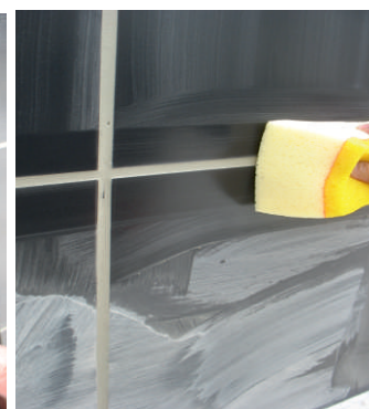
Limpeza do excesso de argamassa
