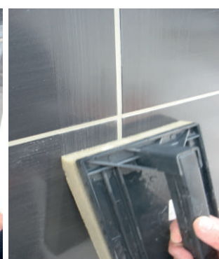
Limpeza do excesso de argamassa
