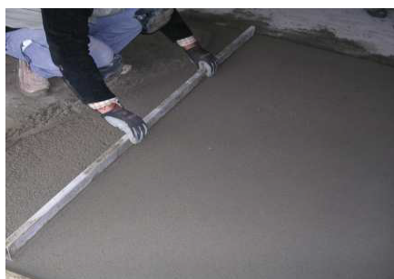
Regularização com régua metálica
