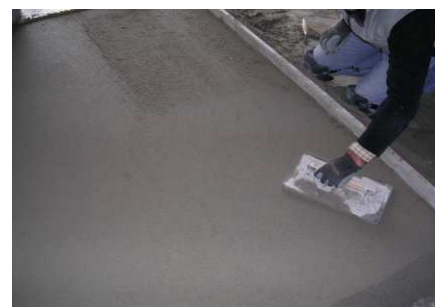
Talochamento da superfície final
