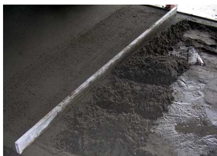
Colocação da argamassa
