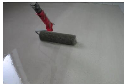
Uniformização da superfície c/ rolo de bicos
